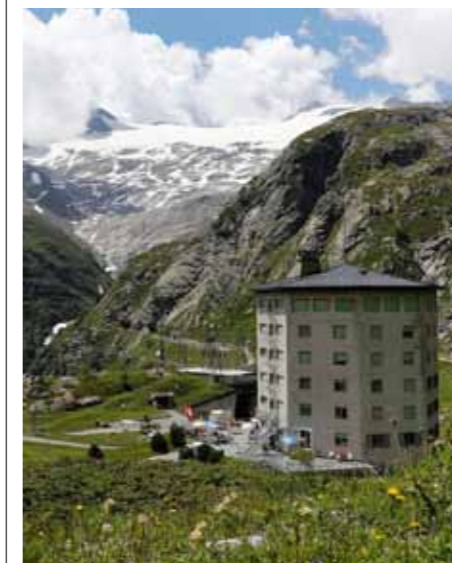
In funicolare verso Robièi e la struttura alberghiera.
